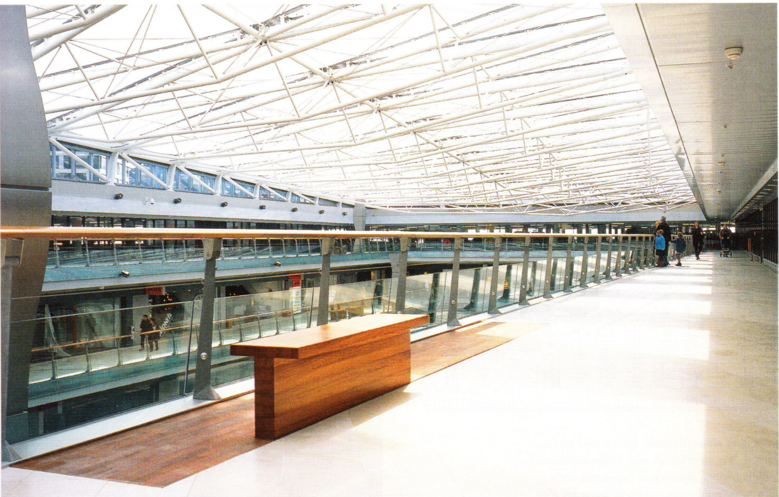
Das Lichtdach besteht aus 105 unterschiedlich großen Luftkissen, die auf einer leichten Stahlfachwerk-Konstruktion lagern.
