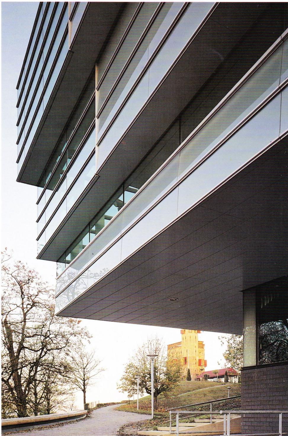
terior del museo a las concepciones de los primeros setenta. En la era de las simulaciones por ordenador, sorprende asimismo que el efecto de luz y color producido por estas lamas sólo se pudiera comprobar mediante la construcción de un prototipo.
